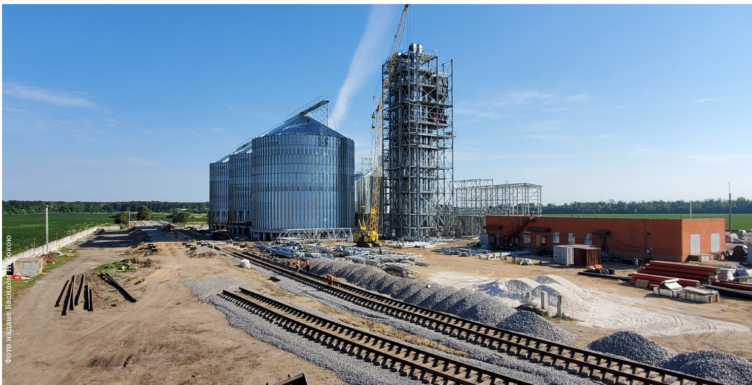
Будівництво нового елеватора у с.Козятин
