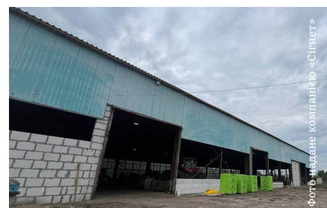
Ремонт будівлі ще не завершено
