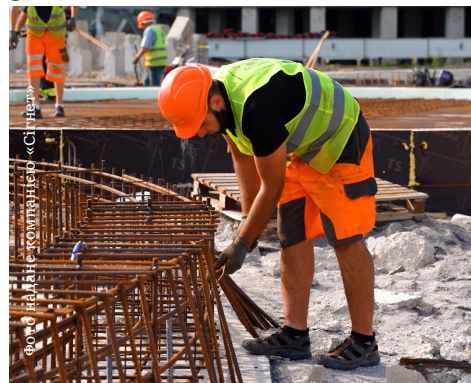
Будівництво на елеваторі в Козятині триває
