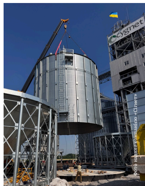
Будівельні роботи в Козятині
